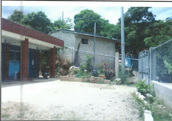
Foto 1: ÁREA DONDE SE CONTEMPLA LA ESTRUCTURA DE LA COCINA TIPO PÓRTICO.
